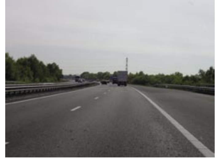
A1 Hoogspanningsmast langs de Arnhemse Weg: eind van de Veluwe
